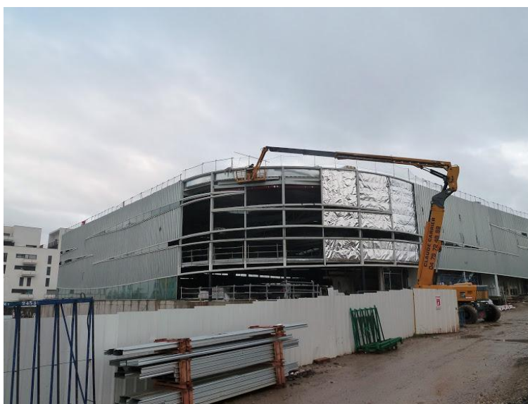
Photo 5 : Halle d'athlétisme en construction (Direction de la Construction, Décembre 2011)
