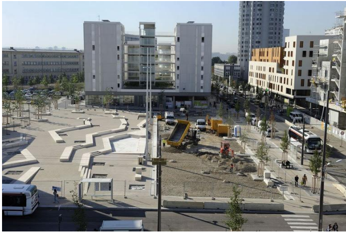
Photo 7 : Place Abbé Pierre en construction en 2011 (©Laurence Danière - Mission Lyon La Duchère)
