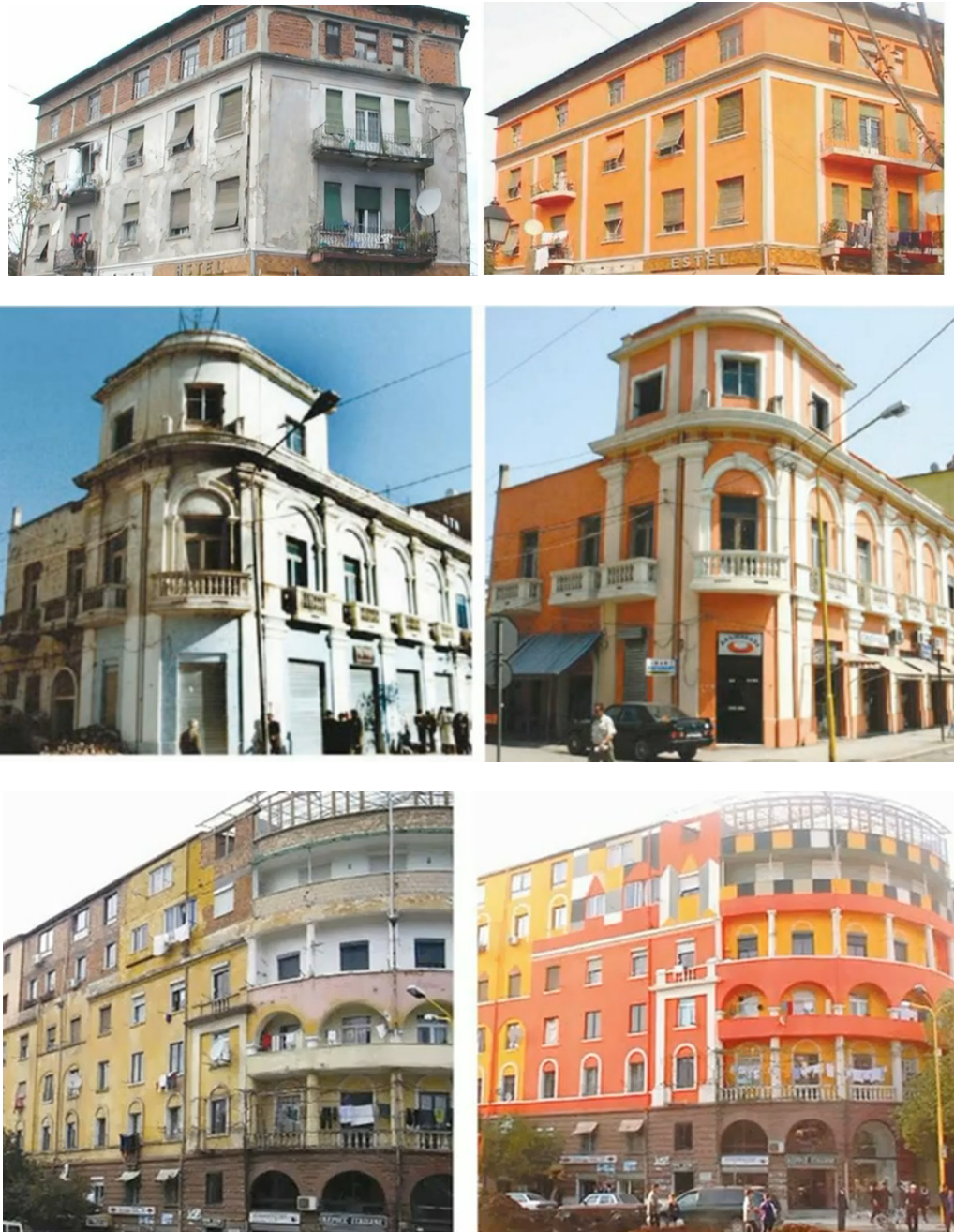
Figure 14 : Premiers bâtiments à avoir été repeint (Avant/Après) (Source : Conférence TEDtalks)
