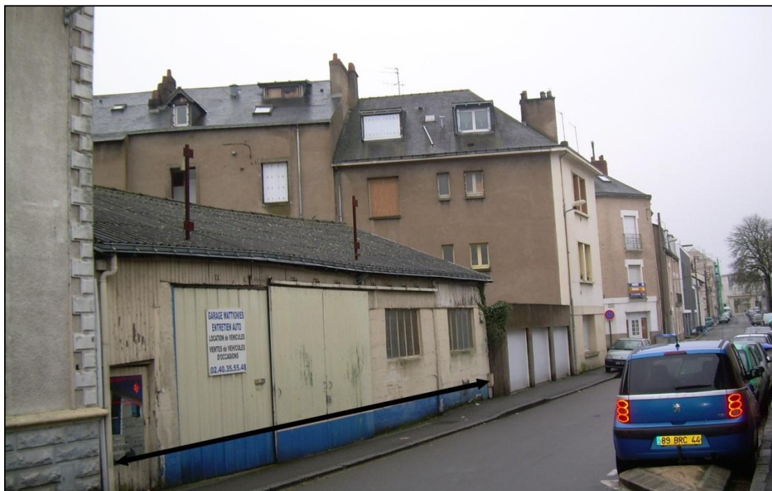
Photo 40 : Emplacement de l'immeuble Babel Ouest (flèche), garage qui a été détruit, Avenue Wattignies, janvier 2008 Photo : Philippe MERIEN, Architecte
