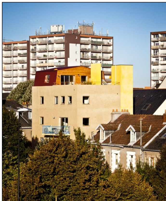
Photo 43 : Immeuble Babel Ouest et son environnement urbain Photo : Franck TOMPS, Atelier du jour
