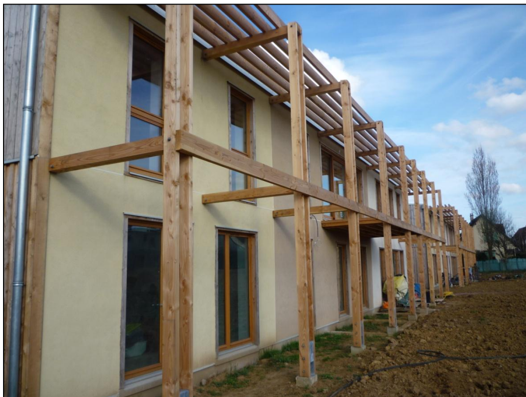
Photo 51 : Première bande de maisons au nord du terrain, façades tournées vers le sud Photo : Aurélie CONNEN DE KERILLIS
