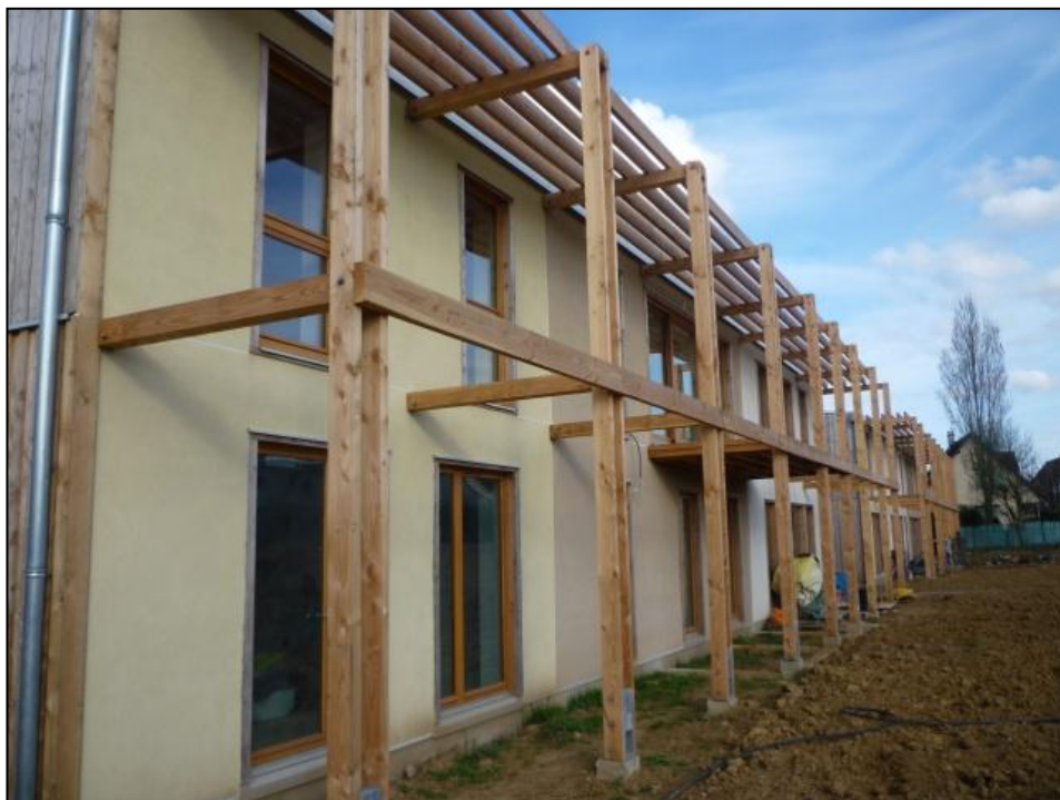
Photo 11 : Première bande de maisons au nord du terrain, façades tournées vers le sud Photo : Aurélie CONNEN DE KERILLIS
