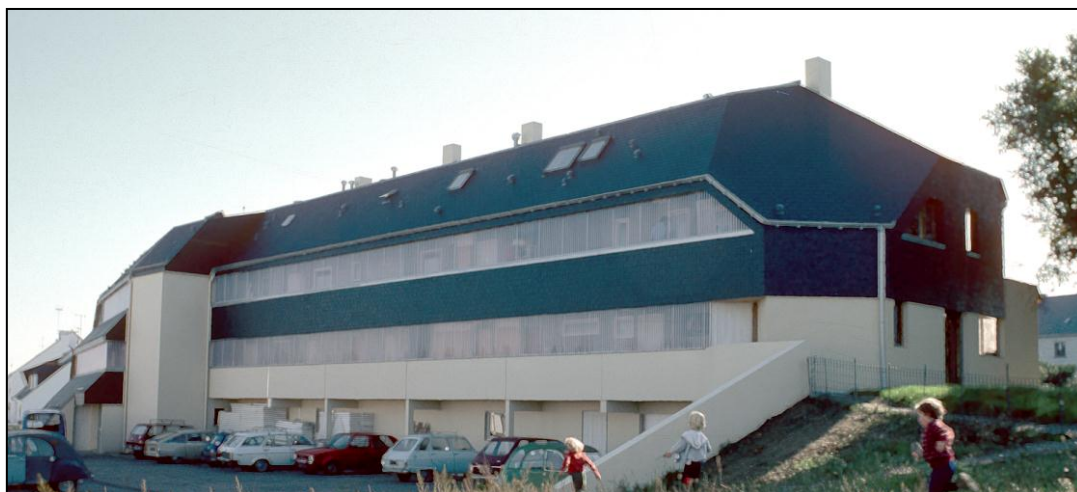
Photo 24 : Aspect du bâtiment avec les coursives fermées par les panneaux plastiques peu de temps après la construction Photo : Christian COCHY, architecte du projet
