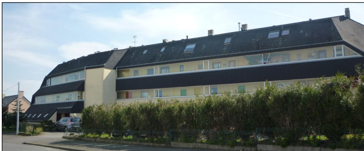
Photo 25 : Aspect du bâtiment aujourd'hui avec les coursives fermées par du verre Photo : Aurélie CONNEN DE KERILLIS
