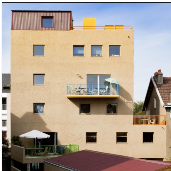
Photo 20 : Aperçu des balcons disposés de façon à pouvoir se parler d'étage à étage Photo : Franck TOMPS, Atelier du jour
