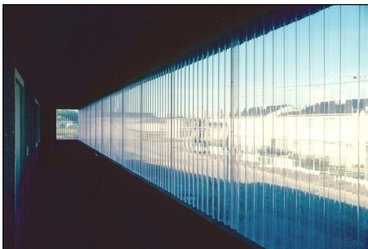
Photo 23 : Panneaux plastiques mis en place par les habitants pour fermer les coursives Photo : Christian COCHY, architecte du projet
