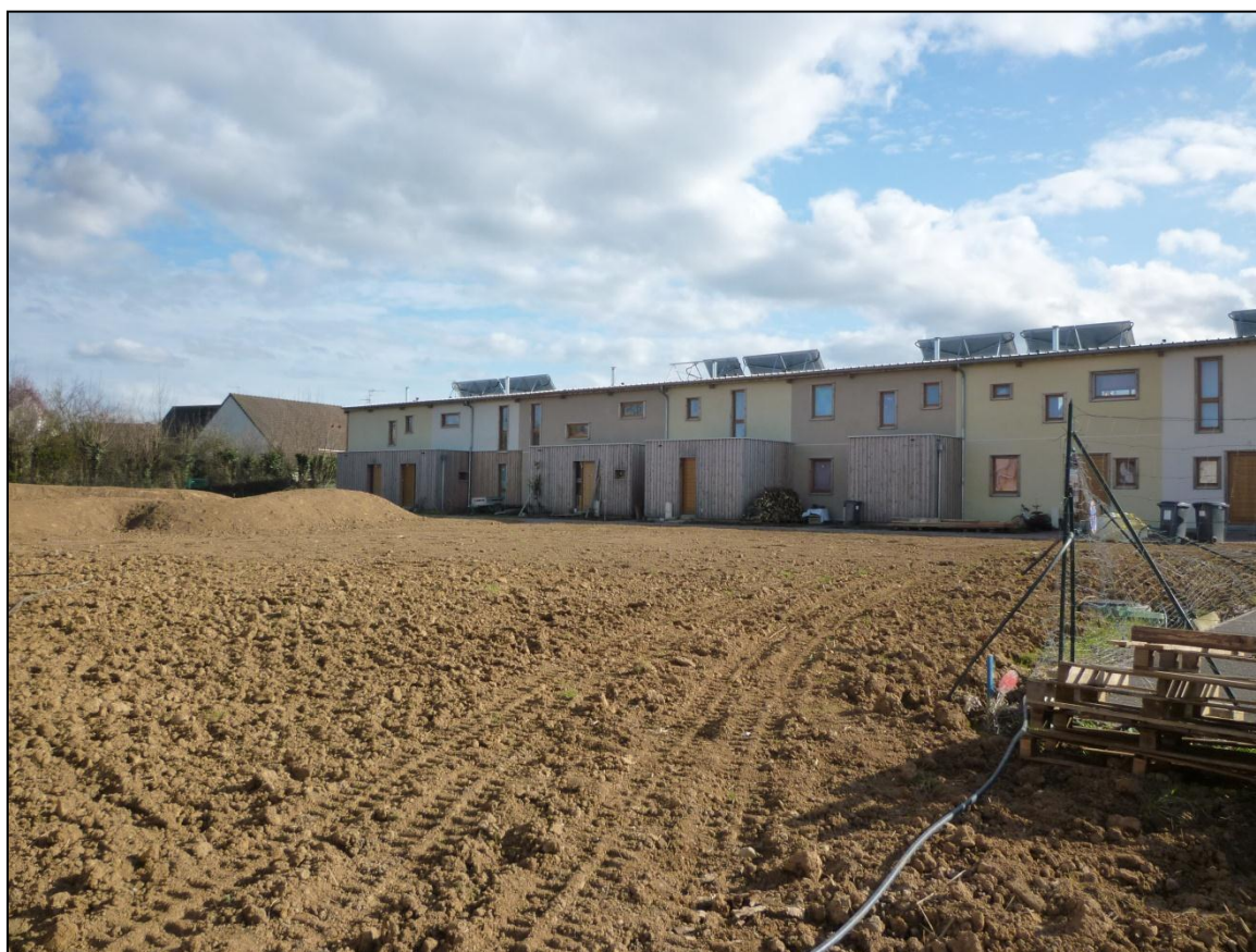
Photo 52 : Deuxième bande de maisons au sud du terrain, façades tournées vers le nord, jardin partagé au premier plan Photo : Aurélie CONNEN DE KERILLIS
