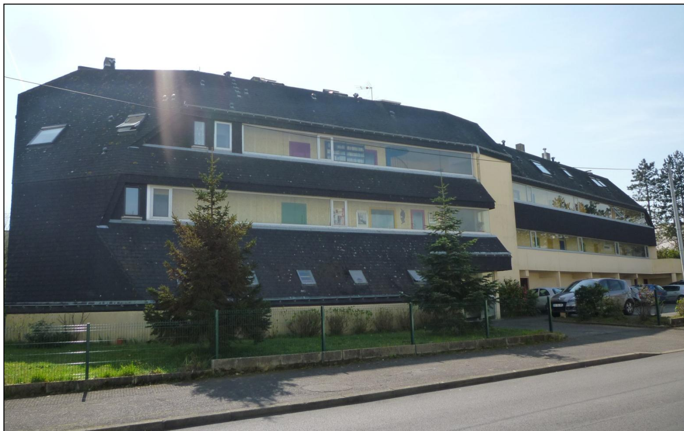
Photo 29 : Façade nord du collectif Photo : Aurélie CONNEN DE KERILLIS
