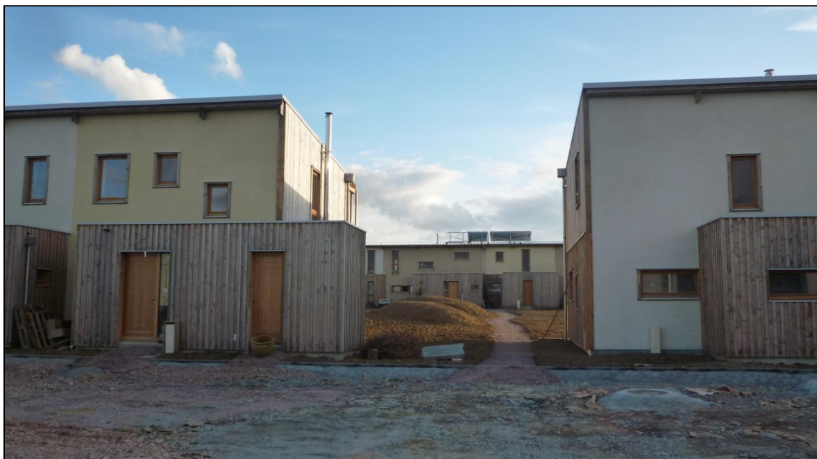
Photo 48 : Entrée principale du projet, au premier plan le parking en cours d'aménagement, la première bande de maisons au second plan, chemin menant au jardin partagé et à la seconde bande de maisons en arrière plan Photo : Aurélie CONNEN DE KERILLIS
