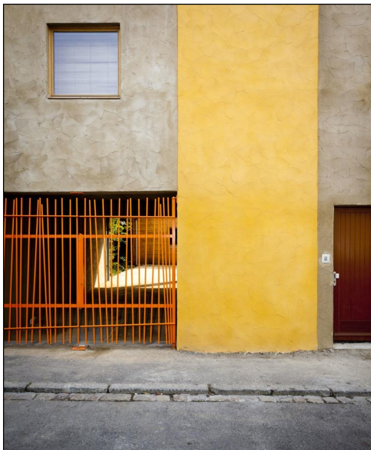
Photo 45 : Entrée piétonne et véhicule (portail orange à gauche) de l'immeuble Babel Ouest, Avenue Wattignies Photo : Franck TOMPS, Atelier du jour
