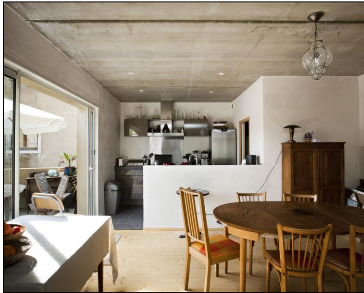
Photo 16 : Planchers précontraints apparents (plafond) Photo : Franck TOMPS, Atelier du jour
