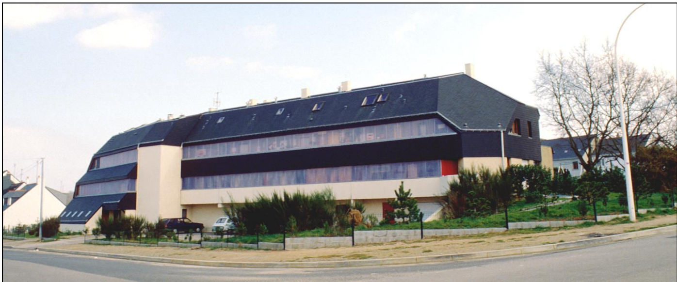
Photo 26 : Bâtiment du collectif La Bosse dans les années 80, peu de temps après l'emménagement des habitants Photo : Christian COCHY, Architecte
