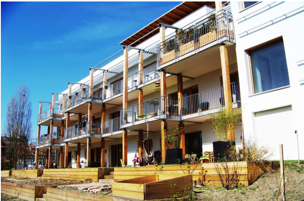
Figure 5 Façade sud du projet Eco-Logis
