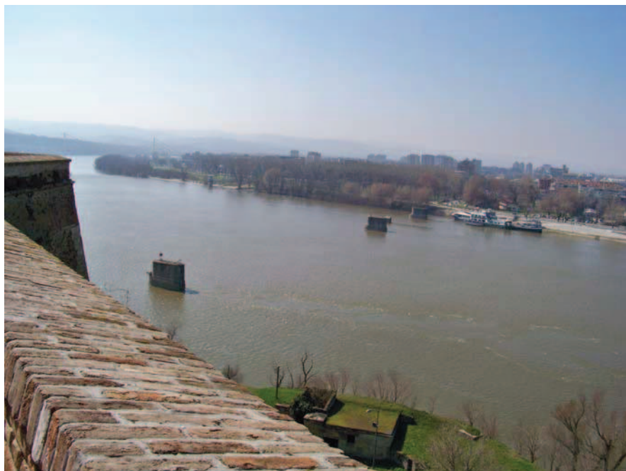
Photographie 25 : Les piles d'un des ponts détruit pendant la guerre
