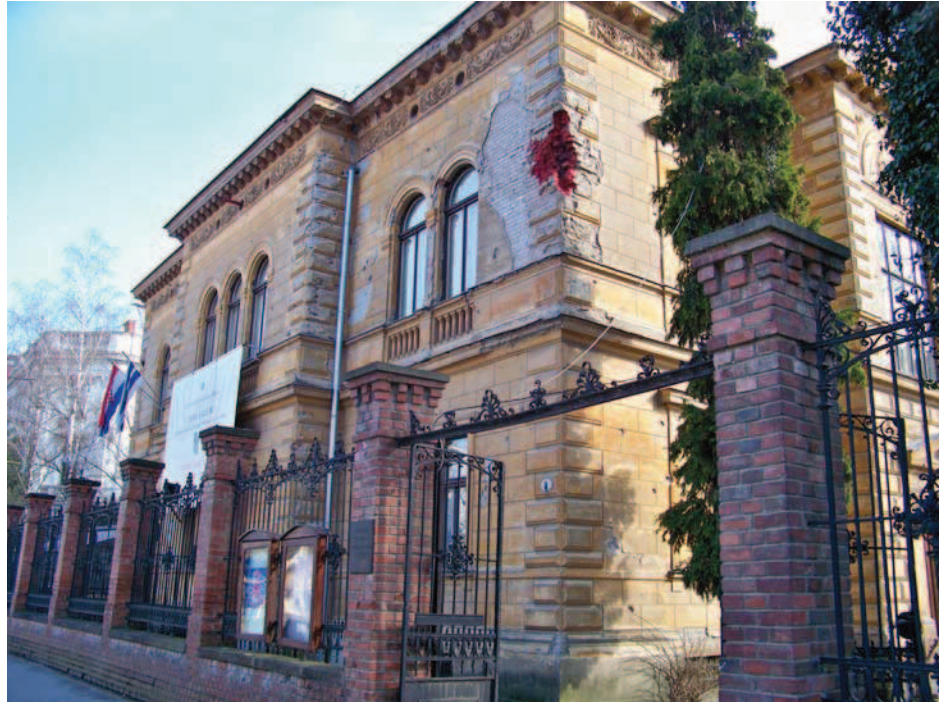
Photographie 2 : La galerie d'art d'Osijek (avenue de l'Europe)
