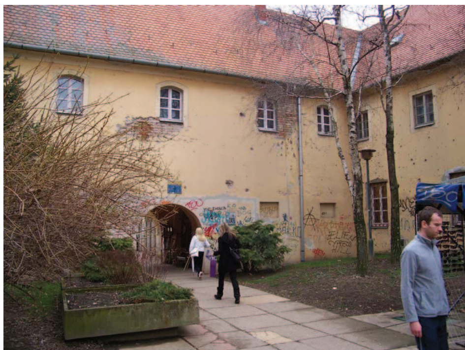
Photographie 1 Impacts d'obus sur les façades la ville
