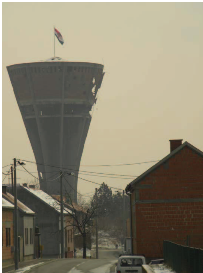
Photographie 7 : Le château d'eau de Vukovar Réalisation : Cyril Barbier
