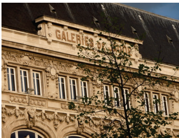
Photo 5 : façade des galeries
