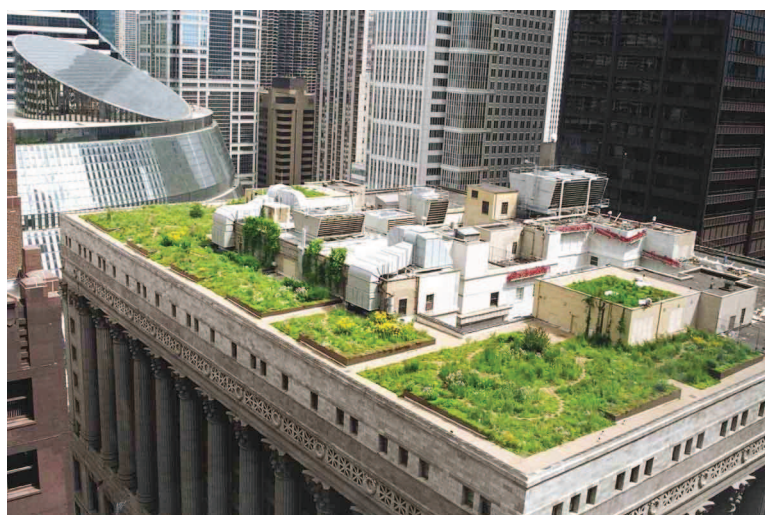
Figure 9 : Green roof d'hôtel de ville de Chicago
