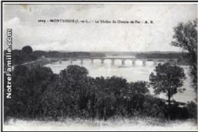
Illustration 8 : Viaduc du chemin de fer à Montlouis-sur-Loire
