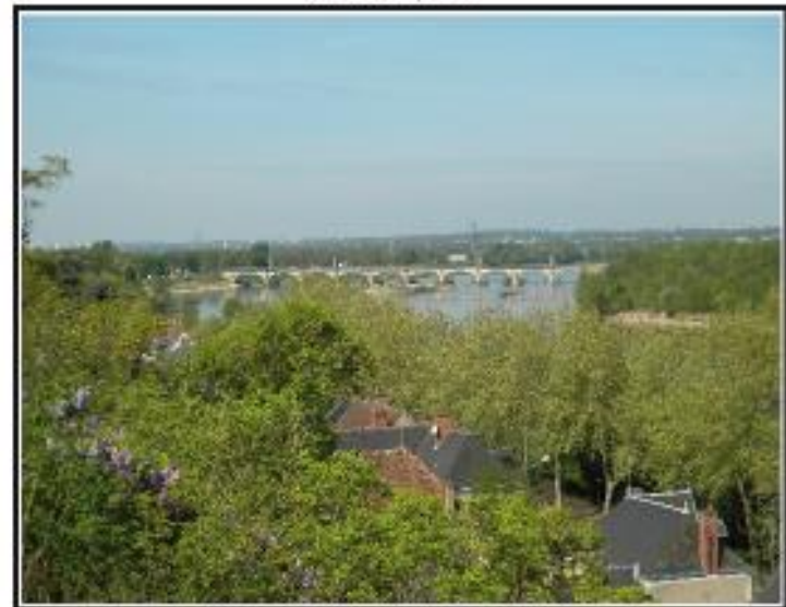
Panorama, Viaduc du Chemin de fer, Montlouis-sur-Loire, 2011
