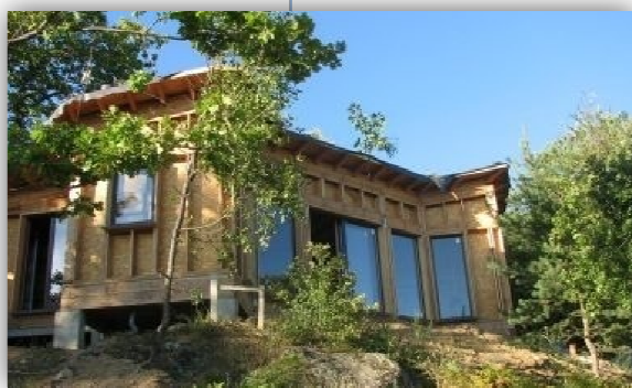
Figure 24 : Habitat en construction
