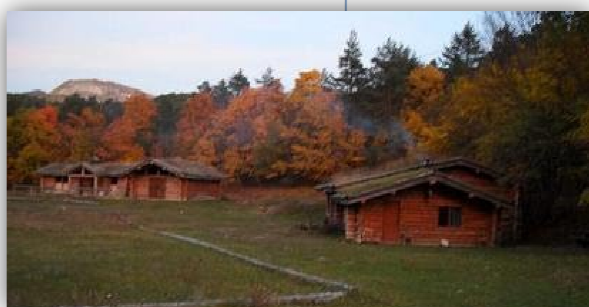
Figure 20 : Bâtiments en fuste de l'éco-hameau
