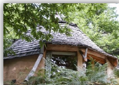
Figure 11 : Murs de paille et charpente de bois
