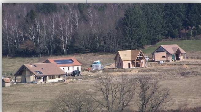
Figure 22 : Vue d'ensemble sur les 3 nouvelles maisons en construction et la maison commune en paille avec son toit photovoltaïque à 100 m des bâtiments de ferme (en 2008)
