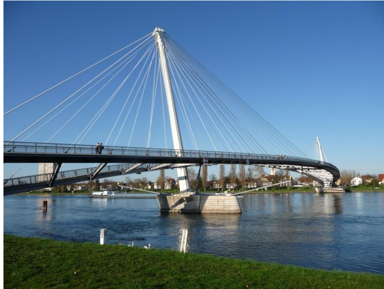
Photo 5: la Passerelle des Deux Rives. (Source : J. Levelu)
