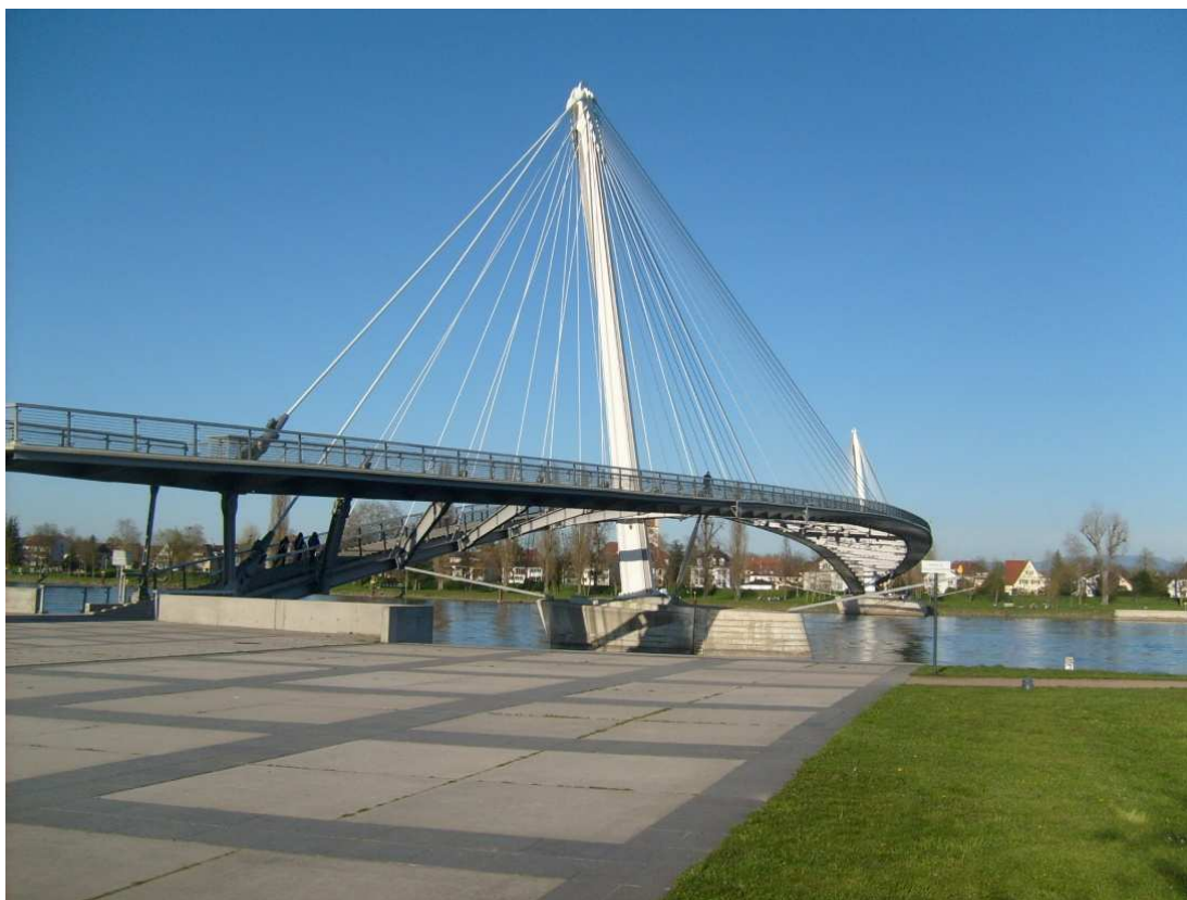
Photographie 7 : La passerelle en forme de bande de Möbius
