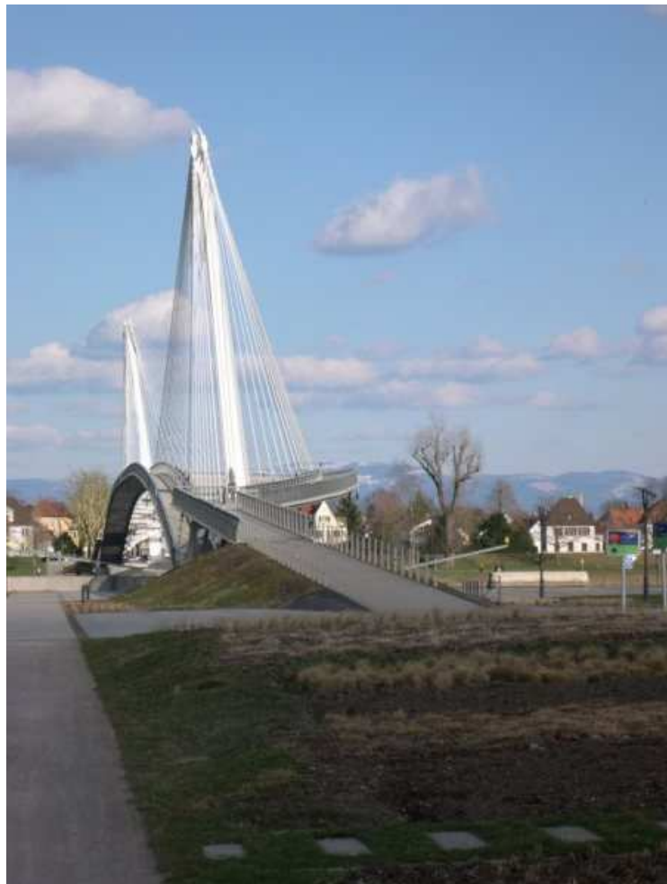
Photographie 6 : La passerelle vue de la rive gauche : deux passages possibles. Réalisation personnelle, mars 2010
