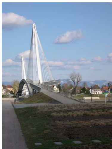
5 : Passerelle vue par la rive droite
